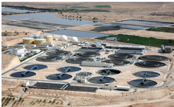
As Samra, Amman (Jordania) – BOT 25 años EDAR + Reuso – 365 mld Turbinas + Biogas AUTOSUFICIENTE EN ENERGIA
